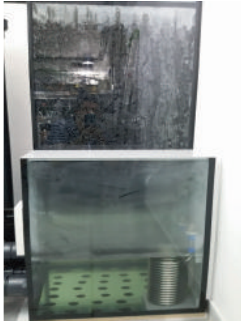
Der Vorfilter und Rieselfilter sind angeschlossen
