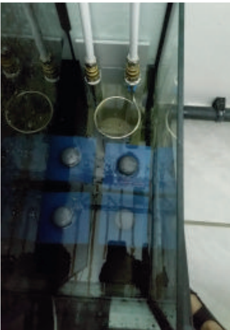
Der Wärmetauscher ist montiert
