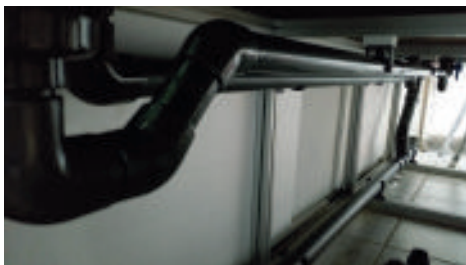
Abflüsse und Zuflüsse sind fertig
