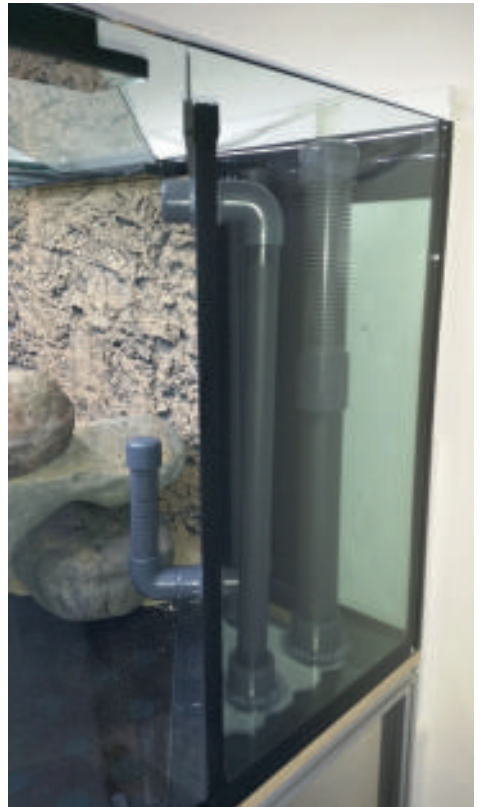
Ein Blick in den fertig verrohrten Überlauf links
