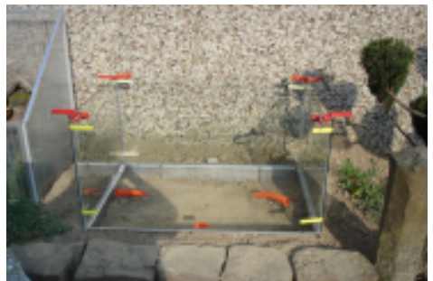
Bild 6: Als nächstes wurden die Scheiben aufgesetzt und mit Silikon verklebt. Die Scheiben sind 60 cm hoch und 6 mm dick.
