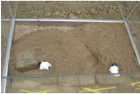
Bild 7: Den Bunker mit einem Gemisch aus Sand, Kies und Erde auffüllen. Dabei ist peinlichst darauf zu achten, dass die Rohre zum Überwinterungsbunker in frostsicherer Tiefe frei bleiben.
