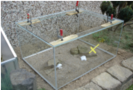
Bild 8: Am oberen Ende der Seitenscheiben verhindern 6 cm breite Glasstege ein Entweichen der Tiere. Sie werden mit Hilfe von Schraubzwingen mit Silikon eingeklebt.
