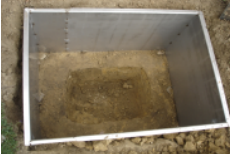
Bild 1: Kasten aus Edelstahlblech 80 x 120 x 65 cm unten offen. Erdaushub etwas größer, in der Mitte eine Grube als Drainagemulde.
