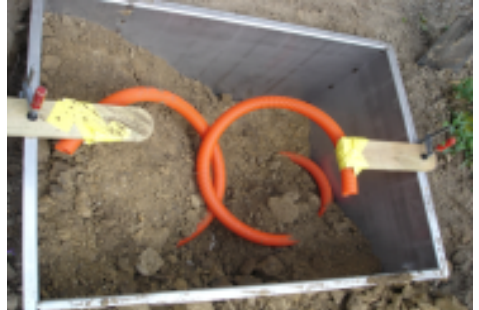
Bild 4: Die Röhre werden spiralförmig nach oben verlegt und der Bunker wird mit Erde gefüllt und verdichtet.
