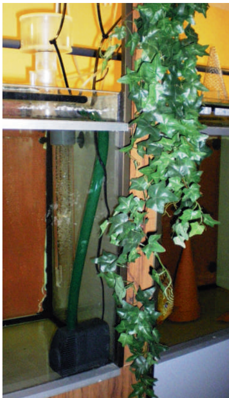
Der Innenabschäumer im Aquarium installiert mit Pumpe zur Versorgung
