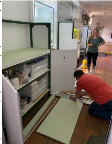
**Auch die Isolierung des Beckens mit Styrodurplatten wurde gleich mitgemacht.**
